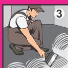
**3** Перед началом работы клей тщательно перемешайте. Нанесите клей шпателем или кистью на основание слоем 1-2 мм.
