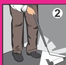
**2** Обработайте основание грунтовочными составами БОЛАРС, соответствующими Вашему типу поверхности. При облицовке печей и каминов использование грунта не рекомендуется.
